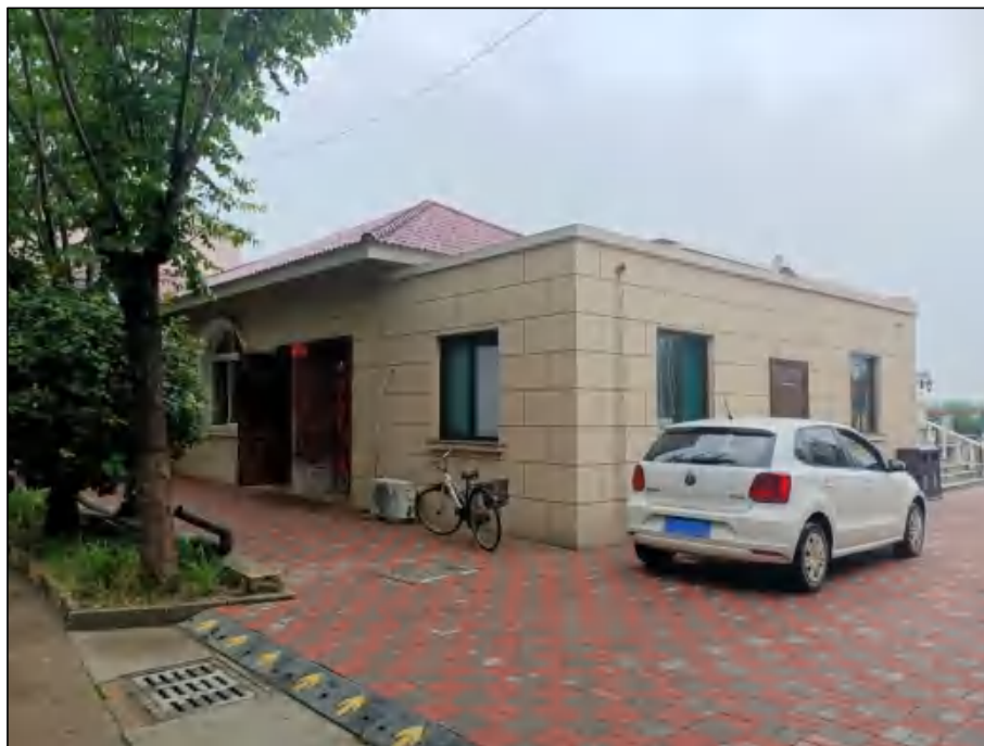
照片1.3-1 R6井室
