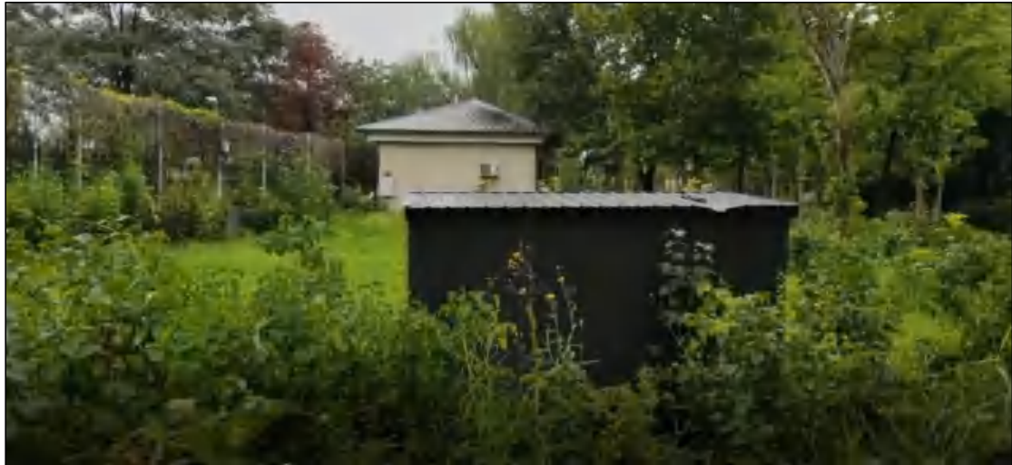
照片1.3-5 R1井室
