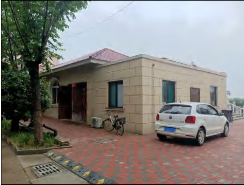
照片3.3-4 R6井室
